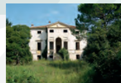
15 - VILLA FORNI CERATO - Montebelluna
